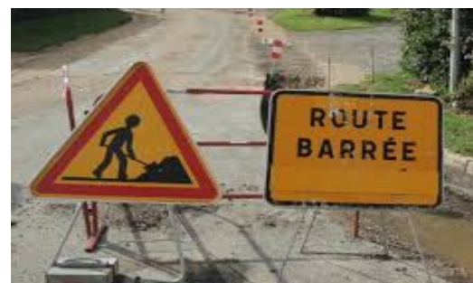
Divers travaux de voirie 10 238,60 €
