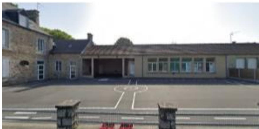
Travaux dans l'école
