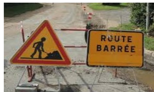
Divers travaux de voirie : 4 443 €
