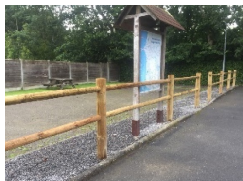
Remplacement de la clôture au boulodrome : 984 €
