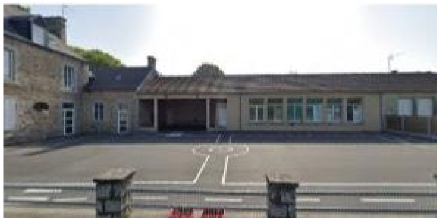
Travaux dans l'école
