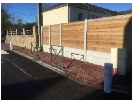
Pose d'une clôture au logement communal : 3 697,73
